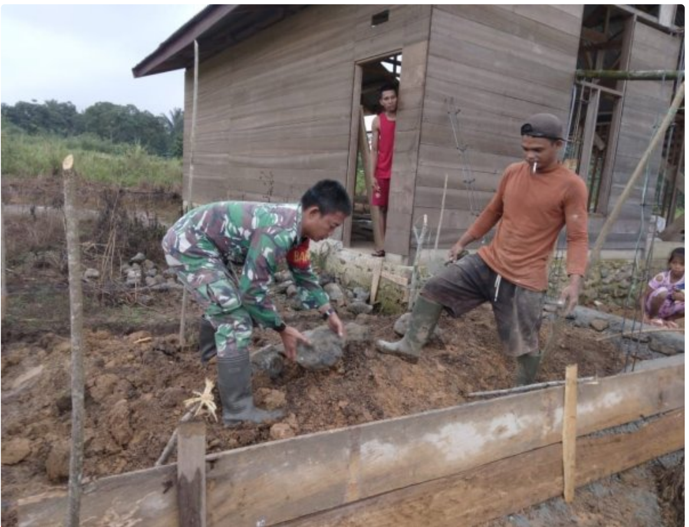
Serda Nonong bantu kerja pondasi rumah warga
