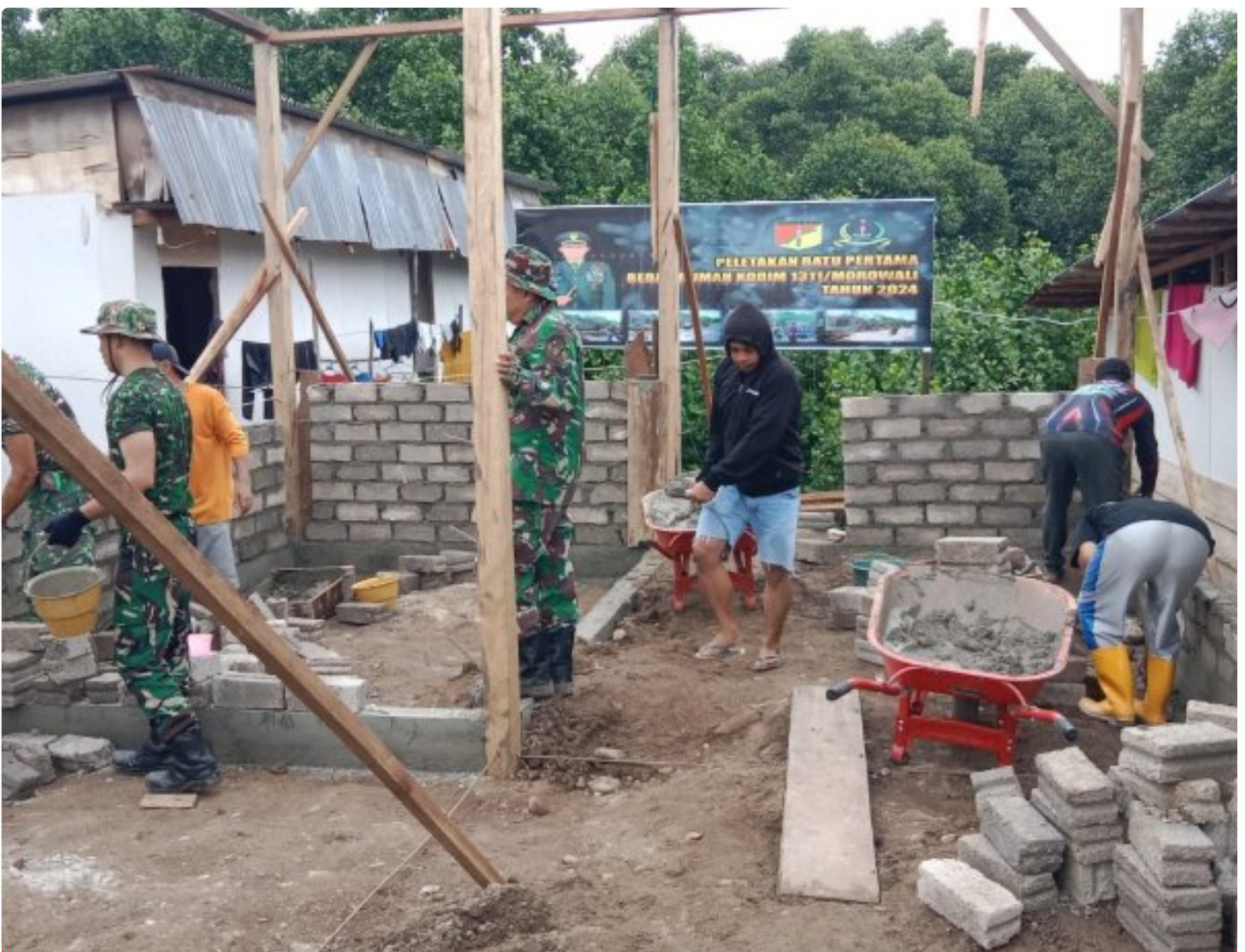
Tampak pengerjaan bedah rumah tahap pemasangan Batako
